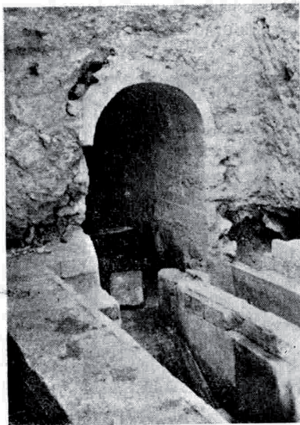
Galería de salida del manantial «Marroyo».
