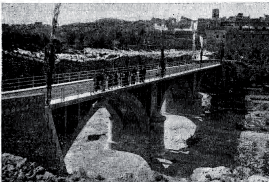
Puente sobre el río Palancia y vista parcial de Algar.
