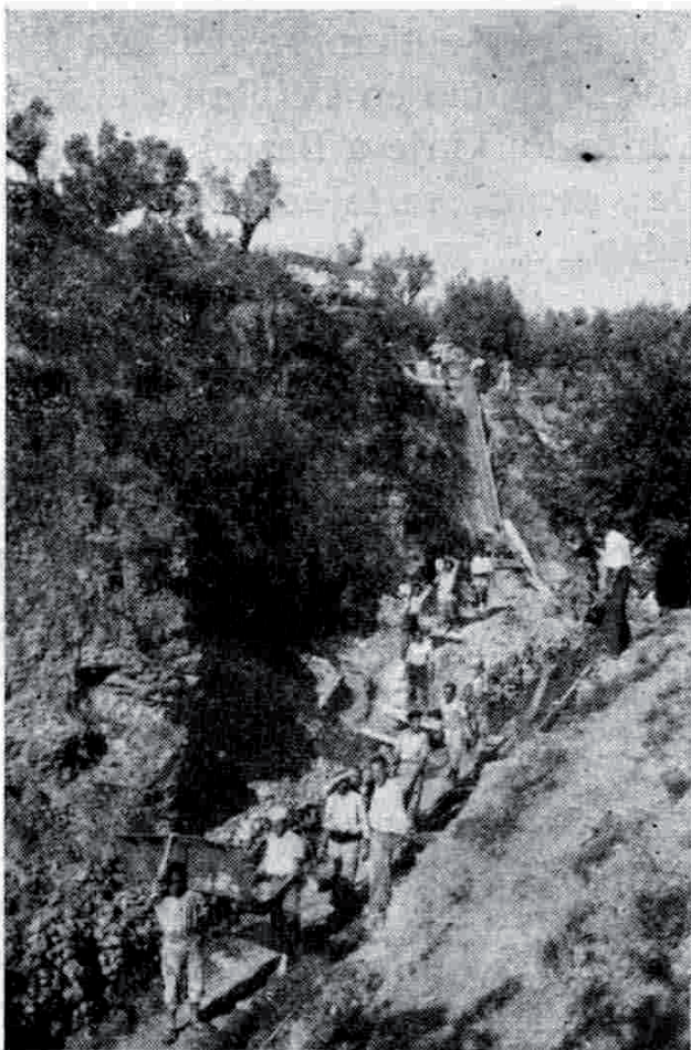
Trabajos en el barranco de San Julián (Marroyo).
