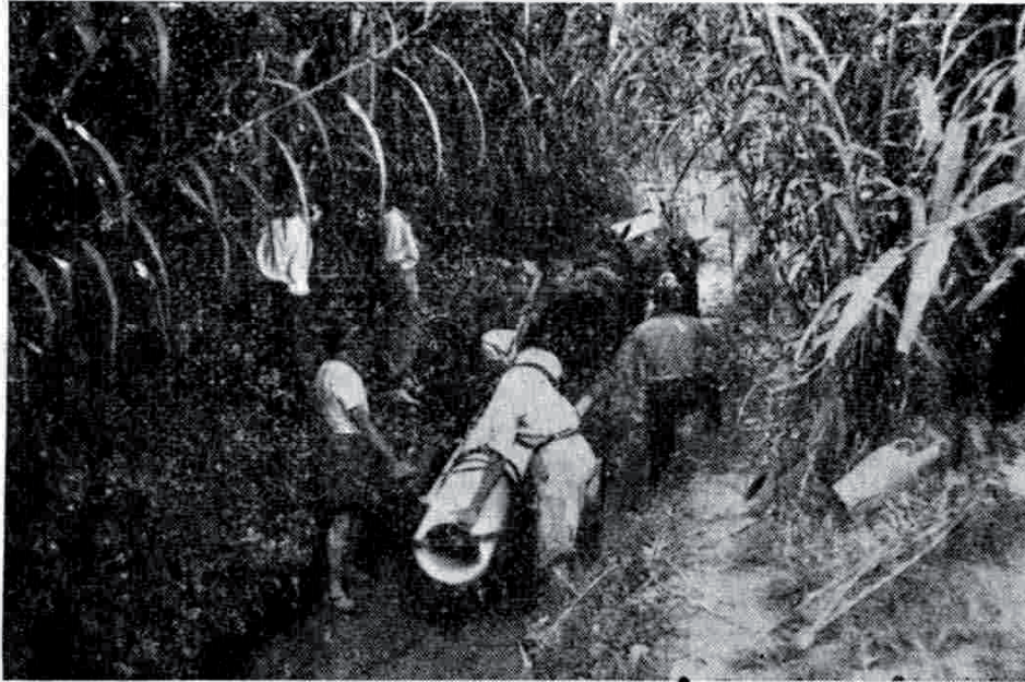
Colocación de tubería Butsen (Marroyo).
