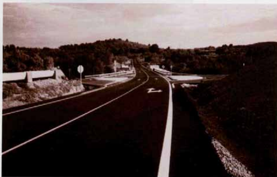
32.- Carretera d'Algar a Alfara, després de la seua reparació i ampliació. (anys 1991/95).
