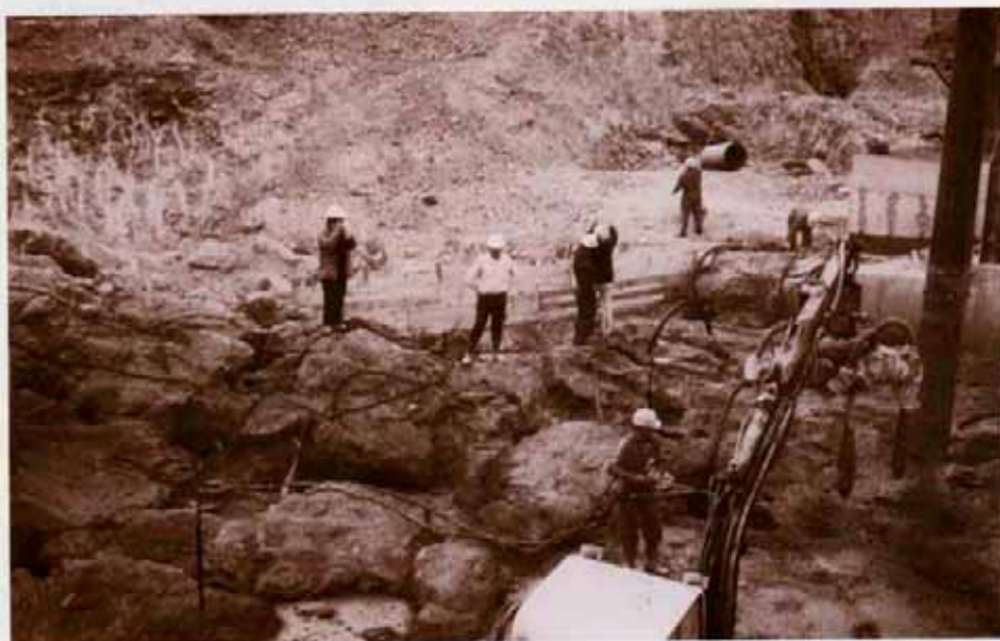
58, 59 i 60.- Obres de construcció de la presa de l'Algar.
