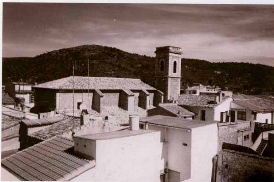
8.- Vista de la Teulada de l'Església, parcialment restaurada. (any 1999).
